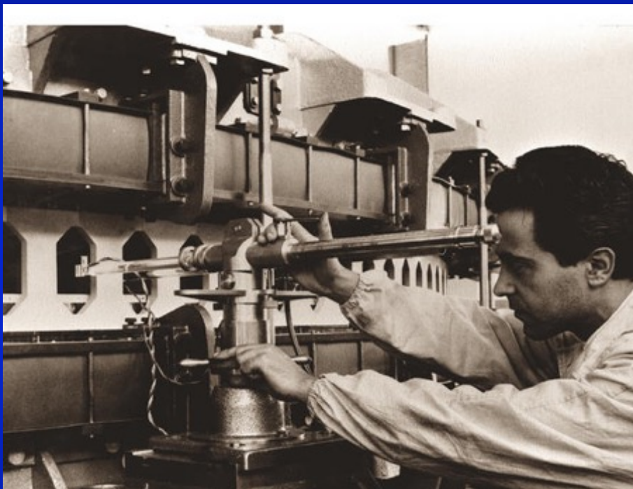
Misure all'interno di un magnete del Sincrotrone. Nella foto: Di Stefano.
